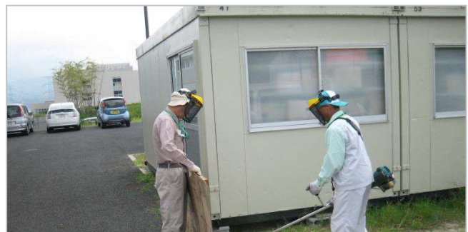
草刈り作業時は養生板で石飛び防止
