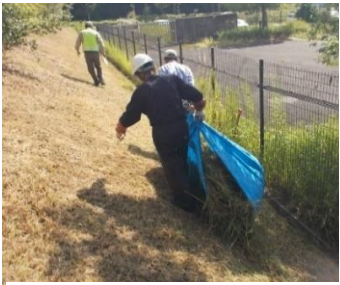
除草作業・国会図書館宿舎
