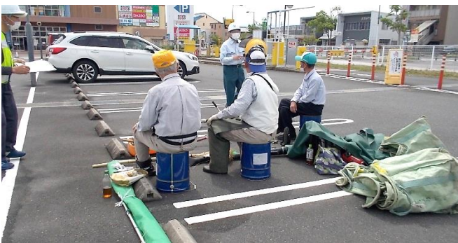
除草・民間施設駐車場
